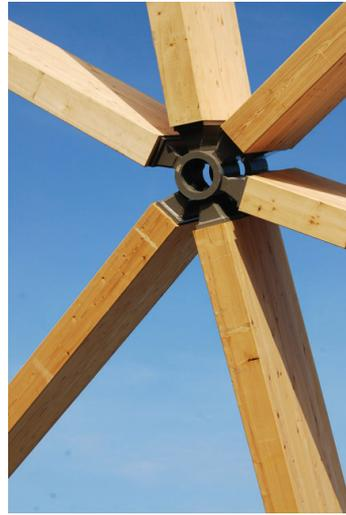
Untereinander sind die BSH-Tragwerksteile über ein patentiertes Rohranschlusssystem – in 3-D-Darstellung (oben, links) und in der Ausführung – kraftschlüssig verbunden. Isometrie: Häring Projekt AG; Foto: © Dr. W. Bogusch
