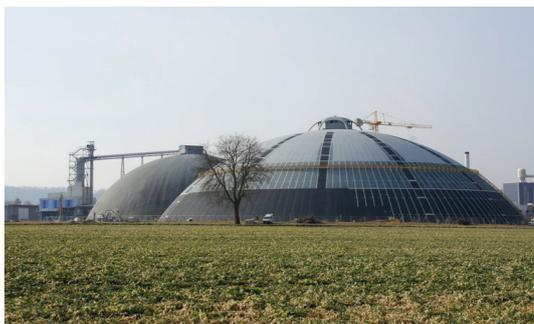
Wie schon beim Vorgänger bietet beim Saldome 2 die gewölbte Kuppelform der Holzkonstruktion (oben) optimale Voraussetzungen für die platz sparende, damit kostengünstige Lagerung von über 100 000 Tonnen Auftausalz (unten).
