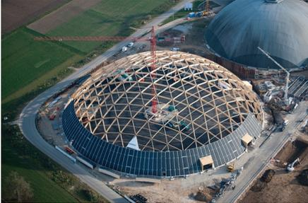
Eine Bestätigung für das bereits beim Bau von Saldome 1 (im Bild rechts oben) Ensphere-Konzept ist die Realisierung des Netzschalentragwerks in einer erweiterten Grössenordnung für Saldome 2.
