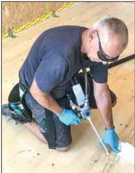
Ein „TS3“-Anwendungstechniker bringt das Gießharz in Einfülllöcher an den Plattenstößen ein. Fotos (2): TS3 AG
