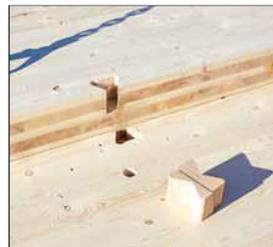
Für die Montage werden die schwalbenschwanzförmigen „X-fix“-Holz-Verbinder eingesetzt.
