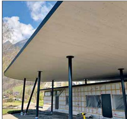
Schilliger Holz lieferte die Großformatplatten, mit denen die Betriebs- und Umkleidegebäude des neuen Strandbades am Vierwaldstättersee überdacht wurden. Die „TS3“-Technologie ermöglicht zweiachsig tragende Flachdecken aus stirnseitig verleimtem Brettsperrholz mit einem Stützenraster von bis zu 8 x 8 m und vermittelt dadurch den Eindruck von besonderer Leichtigkeit der Decke.
