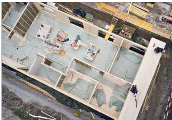
Holzbauweise im Erdbereich trifft auf Nachfrage: Nach Fertigstellung des Pilotprojektes in Thum mit einem Untergeschoss in Holzbauweise gingen bei Timbatec zahlreiche Anfragen ein.
