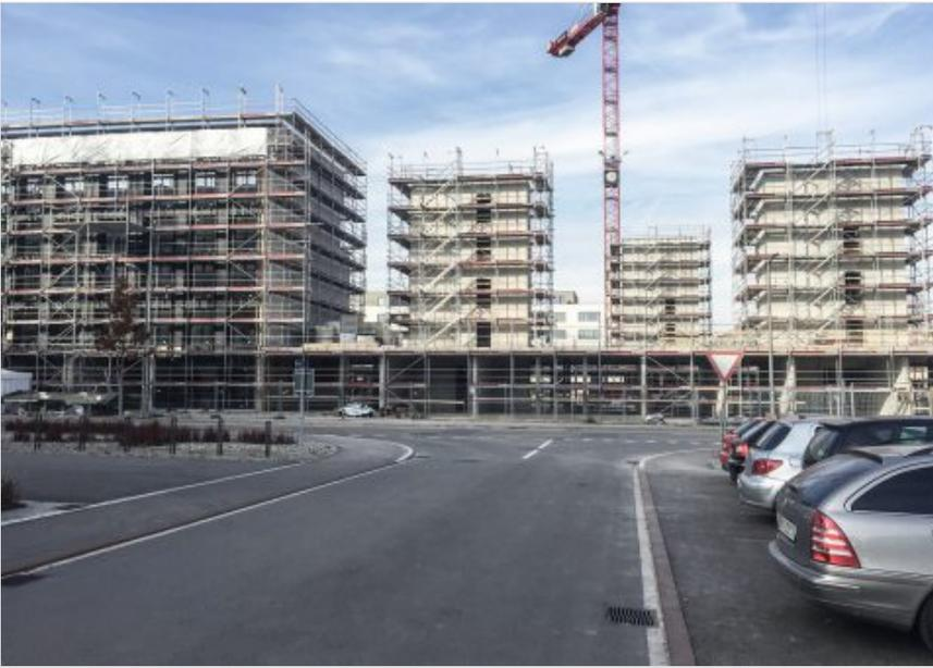
*Sämtliche Wände ab dem ersten Stock sind in Holzelementbauweise ausgeführt.*
