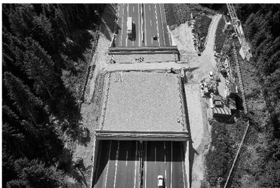
Abbildung 9 Montage der einzelnen Binder zwischen die Portalmodule. Bilder: Astra
