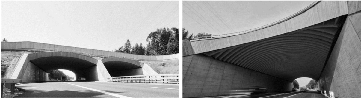
Abbildung 2 Fotos der fertiggestellten Brücke
