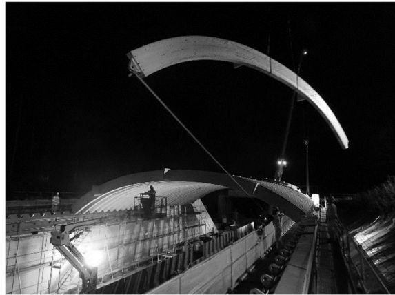
Abbildung 8 Montage der einzelnen Binder zwischen die Portalmodule.
