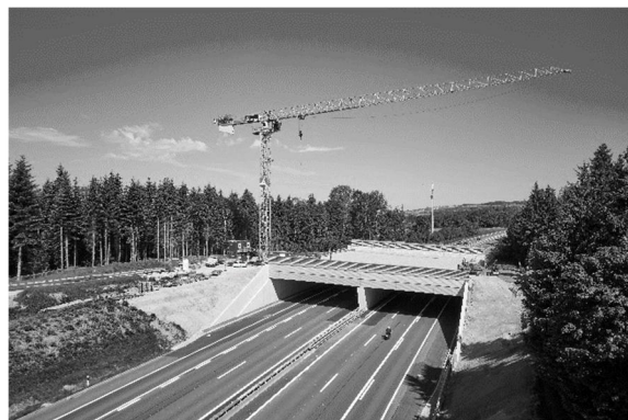
Abbildung 9 Montage der einzelnen Binder zwischen die Portalmodule. Bilder: Astra
