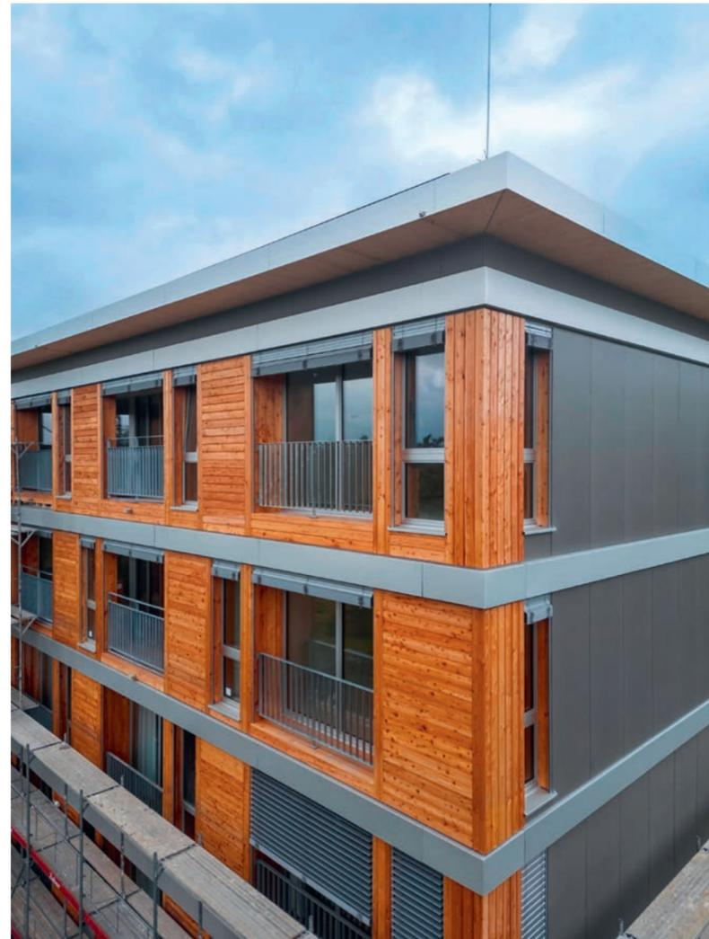
Die Fassadenelemente wurden zimmerweise montiert, die Breitseiten sind mit Faserzementplatten verkleidet.
