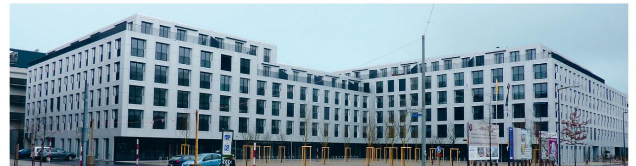
Bei der Überbauung Sue & Til sind Unter- und Erdgeschoss in Massivbauweise realisiert, der Rest setzt konstruktiv auf Holzrahmenbauweise.
