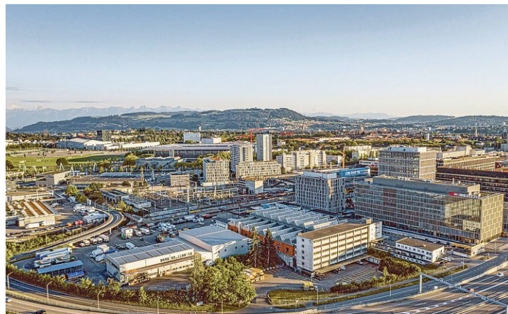
Der Perimeter aus der Luft. Die orange Shedhalle soll nach einer sanften Sanierung für vielfältige Nutzungen vermietet werden. Foto: PD
