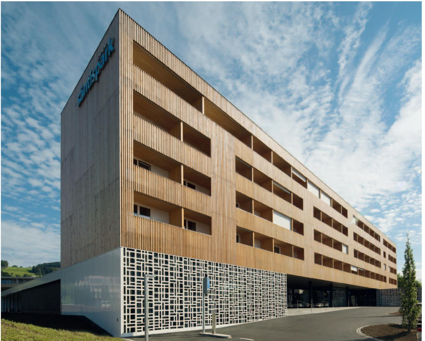
**Der Erweiterungsbau mit Zimmern für das Hotel Säntispark in Abtwil wurde vom ersten bis zum fünften Geschoss in Holzbauweise realisiert. Douglasie in der Fassade und Eiche im Innenausbau prägen die Erscheinung massgeblich.**
