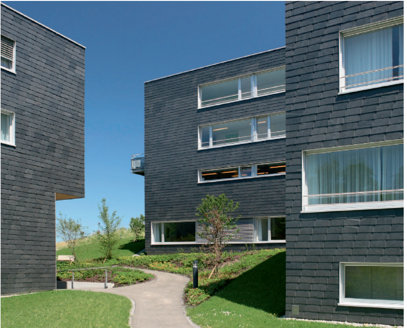
Die drei Baukörper der Siedlung mit Alterswohnungen in Speicher, bekleidet mit anthrazitfarbenem Naturschiefer, bringen Zusammengehörigkeit zum Ausdruck. Architektur: Affolter und Kempfer, St. Gallen
