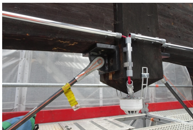
Fixation des barres de traction
