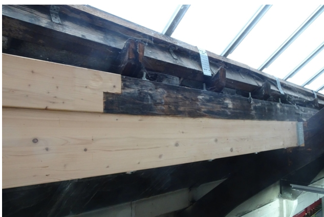
Remplacement des pannes chevron
