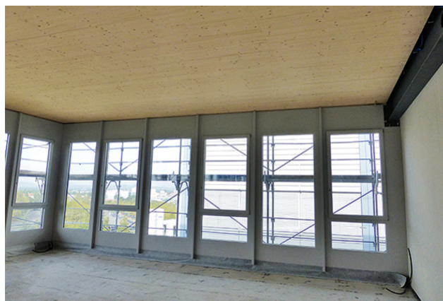
Plafond en bois d'une portée de 9 m
