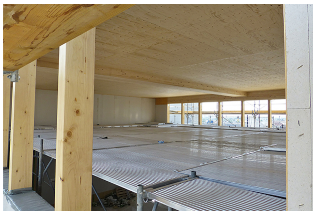
Atrium de plafond de 12 m d'envergure
