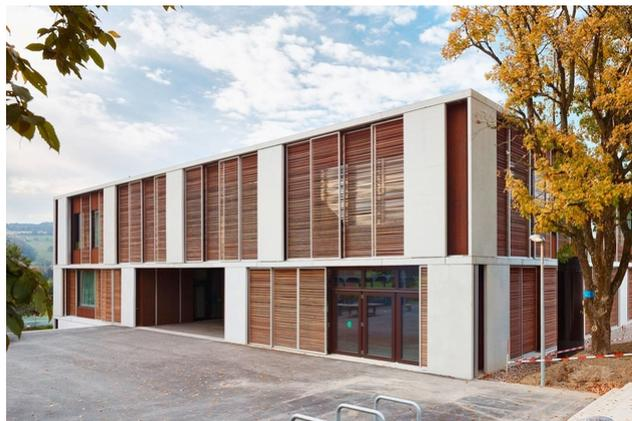
Le bois marque le quotidien des enfants de l'école Schachenmatten à Bonstetten. Le bâtiment scolaire, construit en 2015, est une construction hybride avec des plafonds en béton et des murs extérieurs porteurs en bois. L'exemple le montre : La construction en bois prend également de plus en plus d'importance dans les bâtiments publics.
