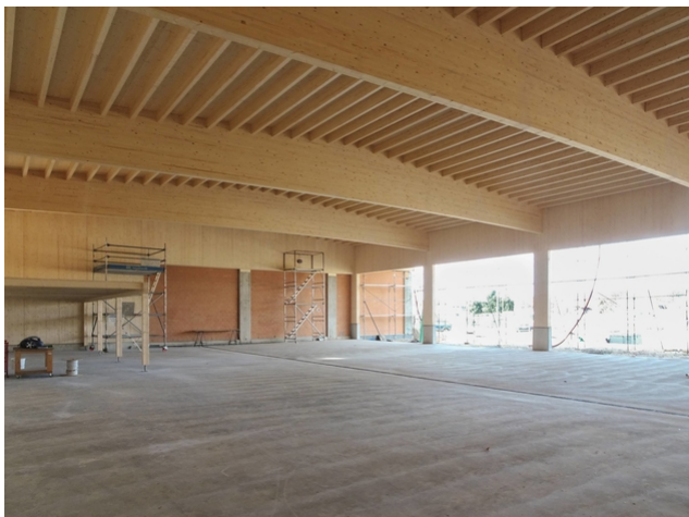
Vue vers l'intérieur : Les traverses de 25 mètres de long supportent le toit du hall
