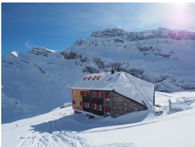
Extra fort : le toit doit pouvoir supporter d'énormes quantités de neige
