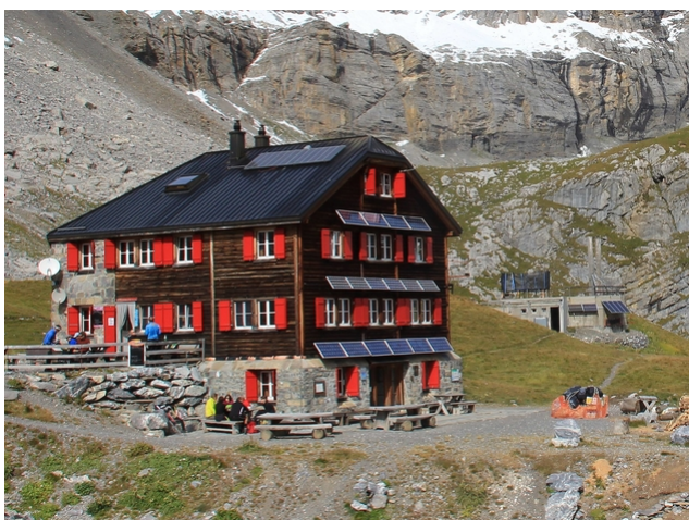
La Lämmerenhütte avant l'extension
