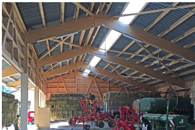
Vue intérieure de la remise
