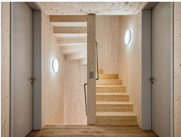
Une cage d'escalier tout en bois
