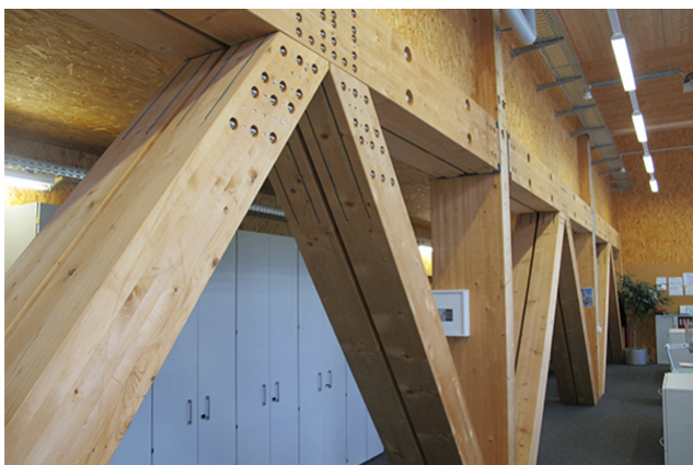
Poutres en treillis dans l'aile des bureaux
