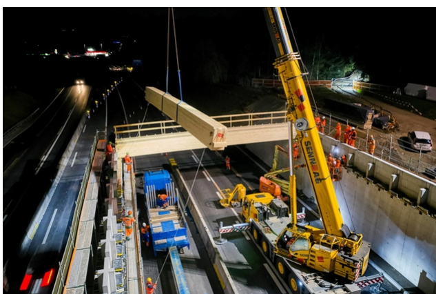
Les poutres pèsent environ huit tonnes
