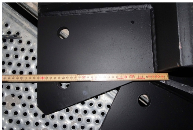
Renforcement des poutres avec des pièces métalliques
