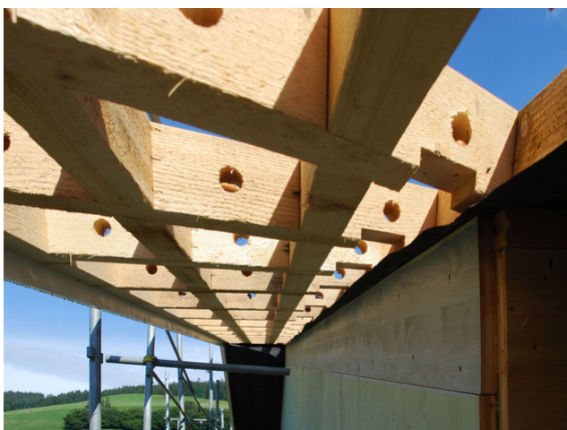
Construction de l'avent
