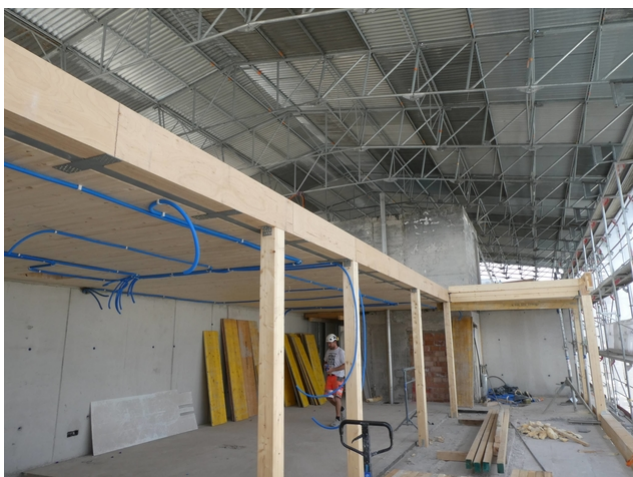
Surélévation sous le toit de secours
