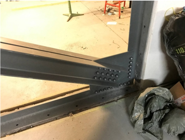
Croix en acier pour le renforcement sismique
