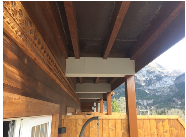
HEB beam clad
