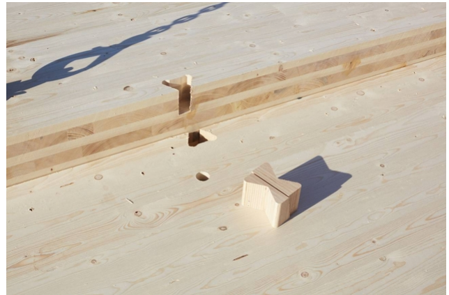
Das Gebäude während der Entstehung
