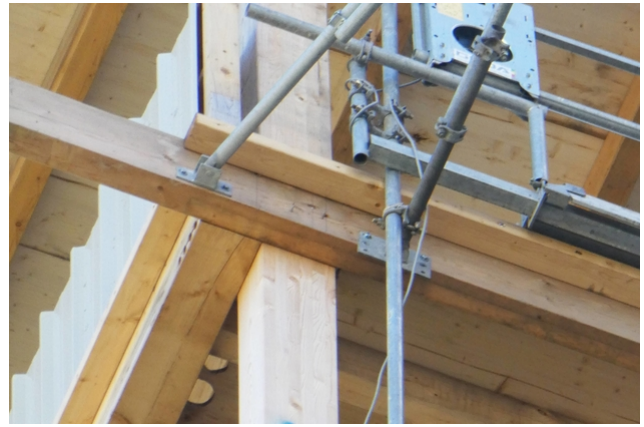
Fire protection transom per floor
