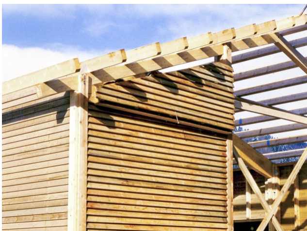
Montage der Wandelemente
