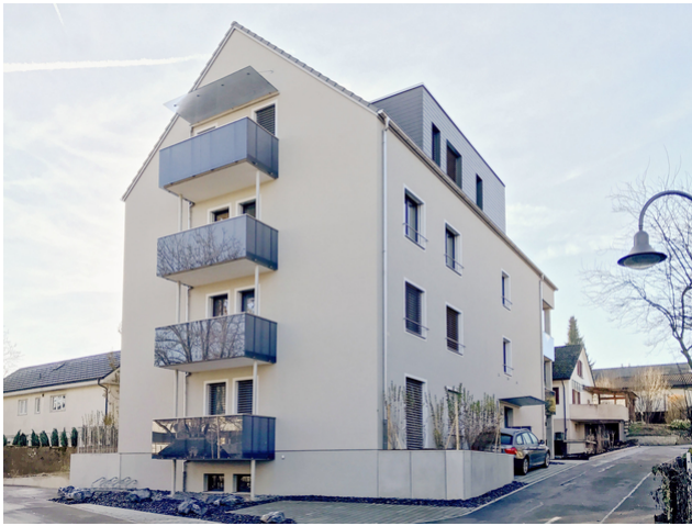
Bergheim: Platz für vier grosszügige Eigentumswohnungen
