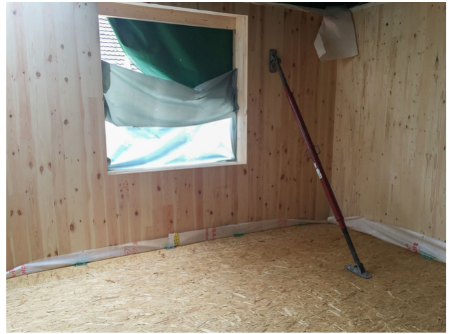
Während den Bauarbeiten: Tragende Aussenwände aus Massivholz
