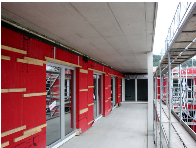
Laubengang im Rohbau
