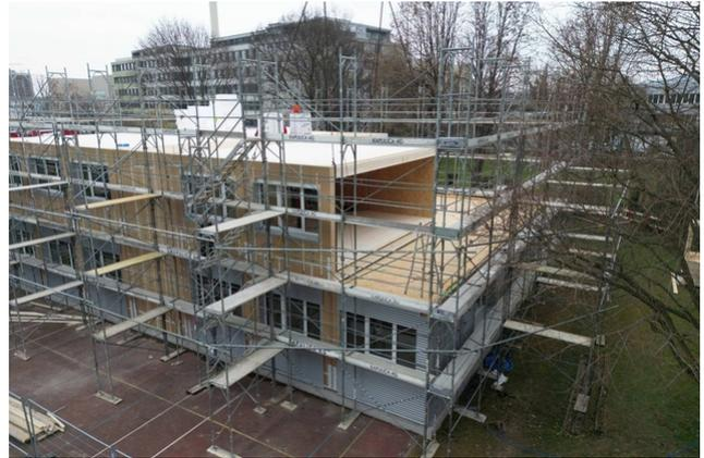
Aufgrund von Schulraummangel entstand ein zweigeschossiger Modulbau auf einem Hartbelagsportplatz. Timbatec unterstützte den Holzbauer in Statik, insbesondere Erdbebensicherheit, Konstruktion und Bauphysik.
