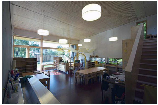
Innenraum hell mit Akustikdecke
