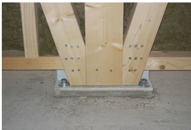
Verankerung Erdbeben-Aussteifung
