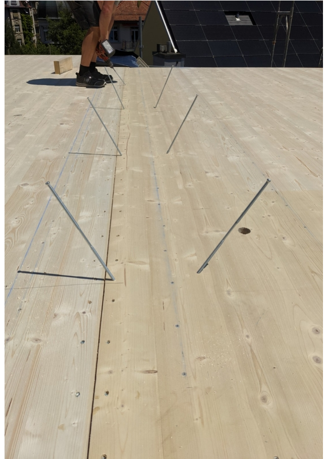
Verschraubung der Dachelemente
