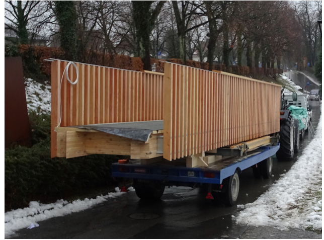
Die Struktur Gewichtung von mehreren Tonnen wurde fahrbereit von einem Sattelzug geliefert
