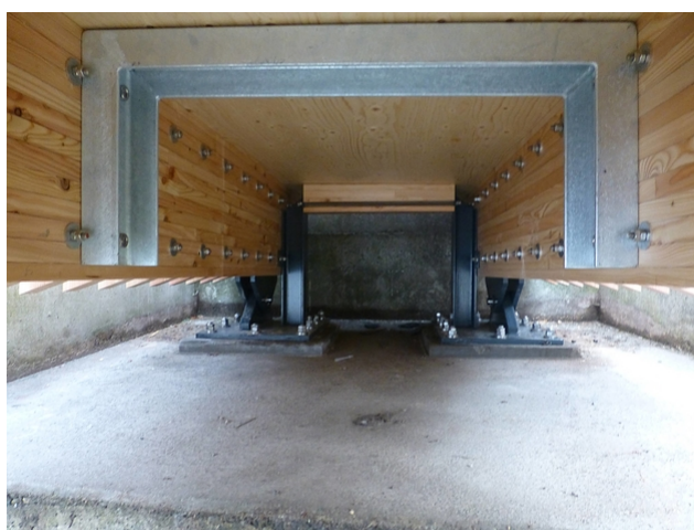
Die neue Brücke wurde in die vorhandene Abutmentnische eingeklemmt
