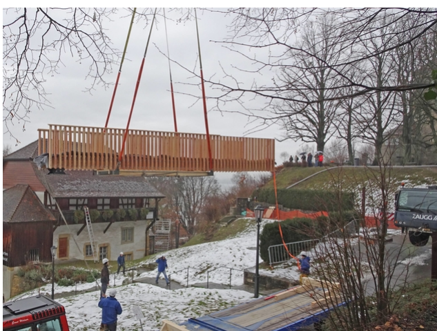
Ein Kran hob die 10,5 Meter lange Brücke an die richtige Stelle
