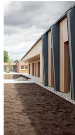
Der offene Bewegungsraum, der einen Teil des Schulungsgebäudes bildet, wurde mit einer Rahmenkonstruktion überdacht. Dabei stellten die höheren Spannweiten, die durch die stützenfreie Grundrissfläche bedingt waren, eine besondere Herausforderung dar.
