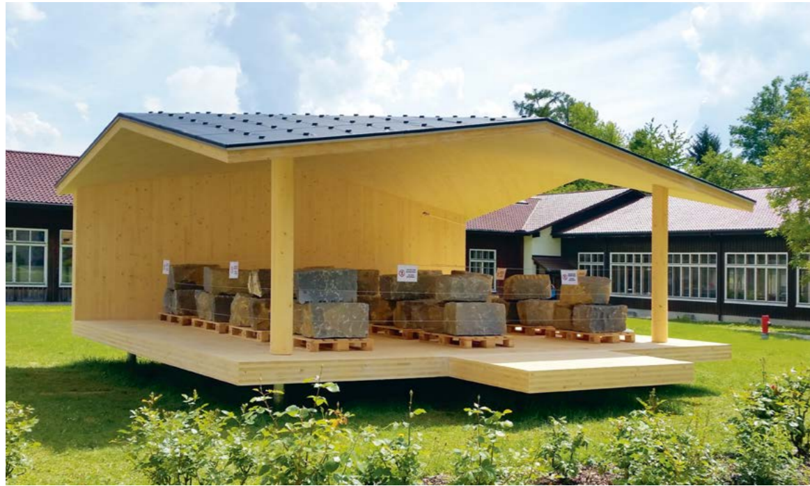
Le prototype TS3 bâti à la Haute école spécialisée pour mener des essais à long terme a permis des avancées importantes.
